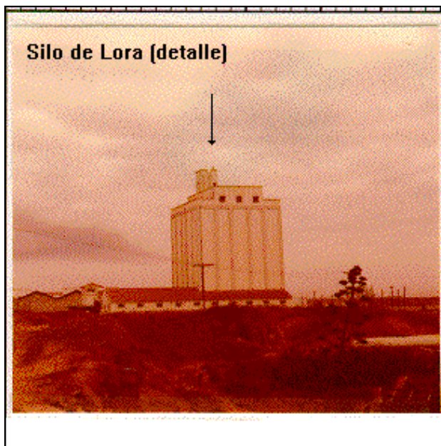
Silo de Lora
