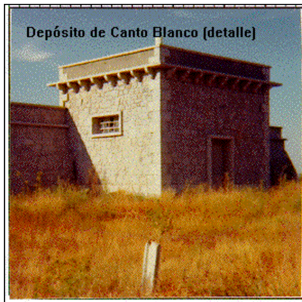
Depósito de Canto Blanco
