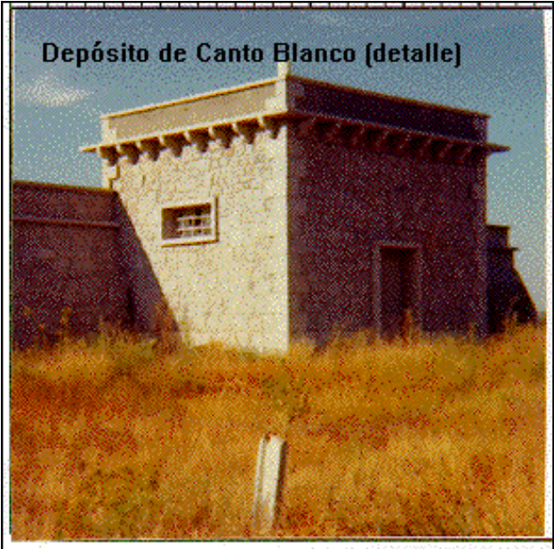
Depósito de Canto Blanco
