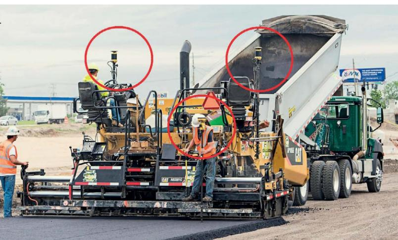
Asfaltado con sensores GNSS.
