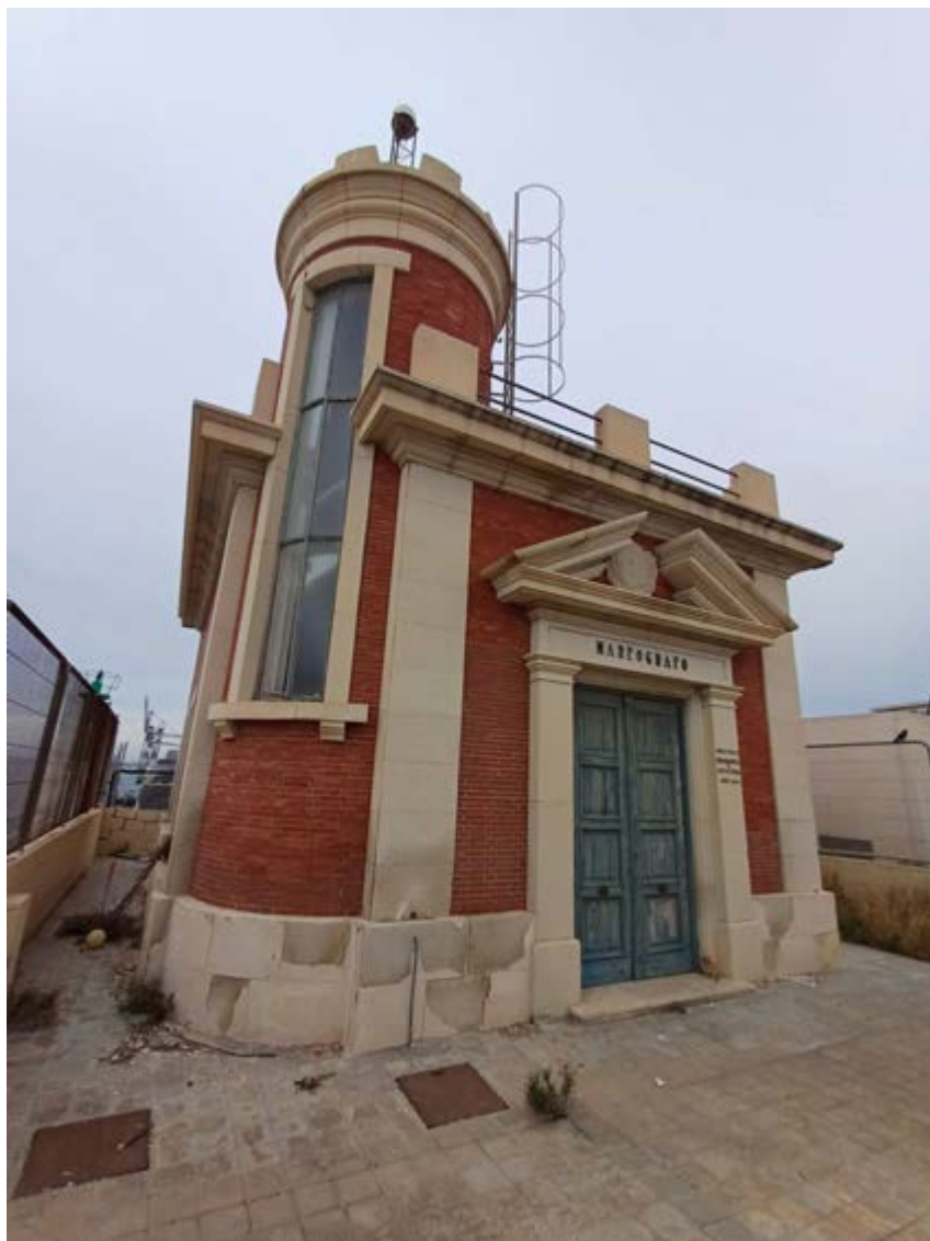
Edificio del mareógrafo Alicante II.
